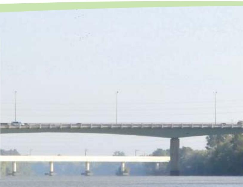
Río arriba, podemos observar el **Puente de la Ronda Circunvalación SE-30**, proyectado a Sevilla con el **Puente del Alamillo** (en un principio iba a ser como éste) en la dársena. Este puente, de hormigón armado y construido en 1991, supone la principal vía de unión entre el norte de la ciudad y el Aljarafe. Es parte de los 22,3 km de autovía de circunvalación que rodean a Sevilla, la SE-30.
